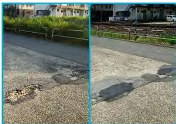
一部では鉄筋が見えるほど陥没していた幸町1-3付近の線路脇道路が補修されました。
